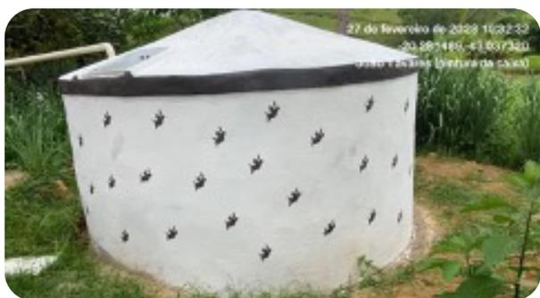
“A ideia principal desse sistema é captar a água da chuva e direcioná-la para um reservatório, construído com placas de cimento pré-moldadas. A captação da água de chuva é feita pelas calhas, que levam a água para armazenamento, ali, a água fica protegida e pode ser usada pelas famílias no período de estiagem, ou ainda, para a manutenção da horta e do quintal.
